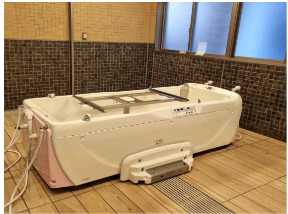
▲ 케에세이카이의 첨단기술이 접목된 목욕설비 (대상자가 직접 움직이지 않아도 침대에서 욕조로 이동 가능하게 설비)
