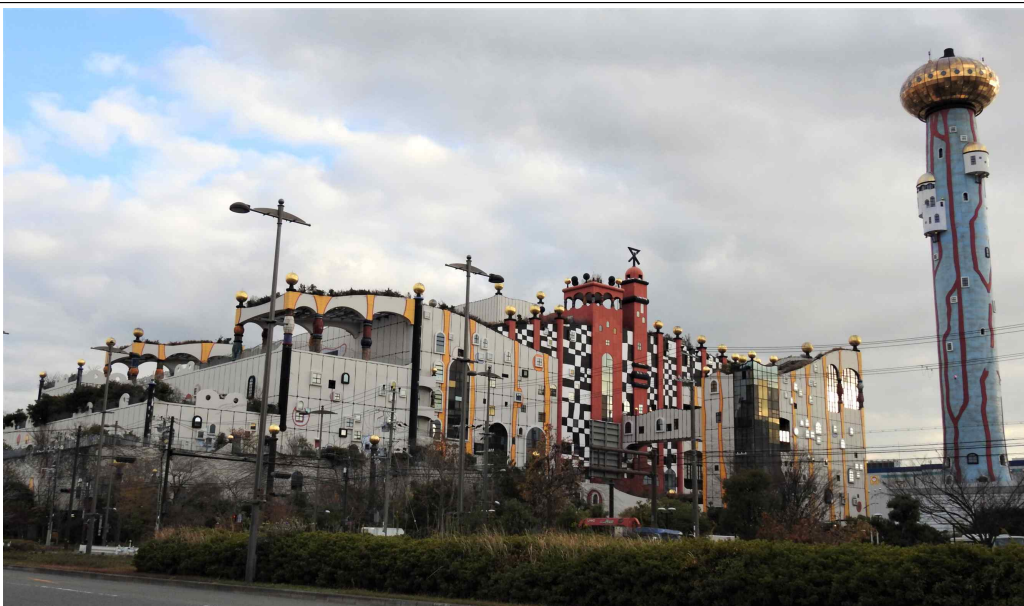
오사카 마이시마소각장 전경
