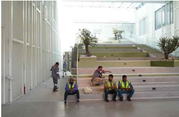
시설보수 중인 커뮤니티시설
